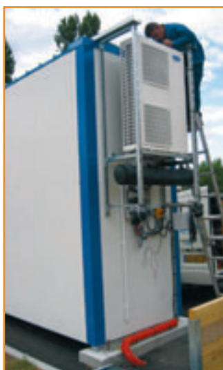
Climatisation ADF avec traitement d'air à l'intérieur de l'armoire. Groupe de production chaud/froid maintenu sur châssis acier avec réserve d'eau en dessous
