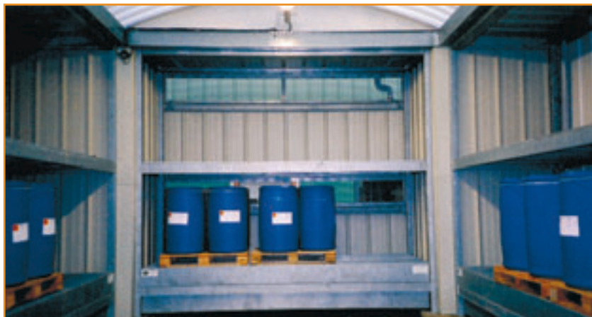
Vue intérieure avec grilles d'aération spéciales
