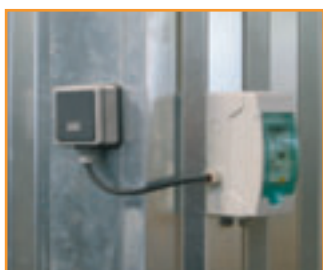
Interrupteur extérieur + coffret électrique pour éclairage standard ou ATEX*
