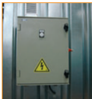
Coffret électrique pour maintien hors gel ou ventilation standard ou ATEX*
