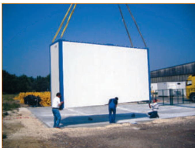
Anneaux de levage fournis pour déchargement à la grue
