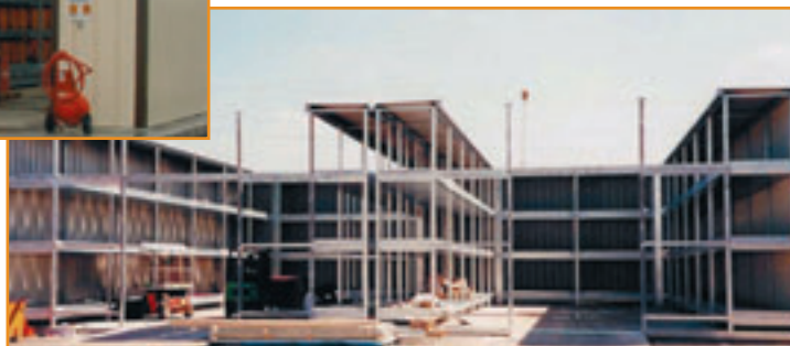
Structure magasin sur 3 niveaux en cours de montage
