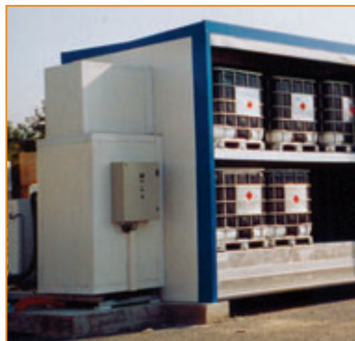
Groupe de climatisation réversible pour une armoire double face
